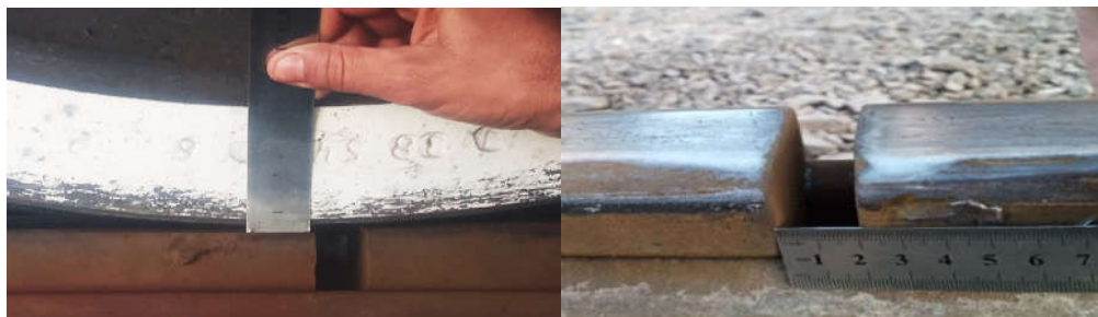
Рис. 1. Общий вид стыковой неровности путей промышленных предприятий Fig. 1. General view of a joint irregularity on industrial railway tracks
