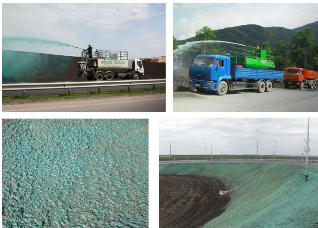
Р и с. 1. Фото гидропосева газонной травы
