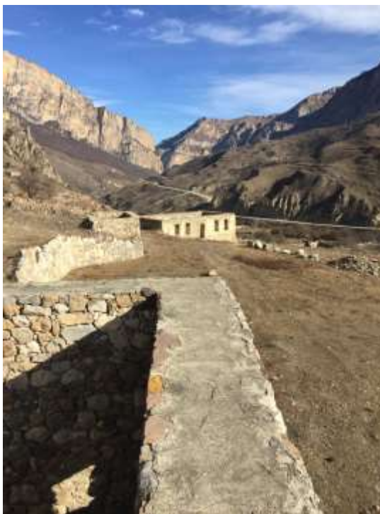
Илл. 1. Руины аула Зилги (балк. – Зылгы). Верхняя Балкария.
