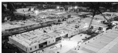
Пандемический госпиталь на 1 тыс. мест., Ухань, Китай, 2020 г.
