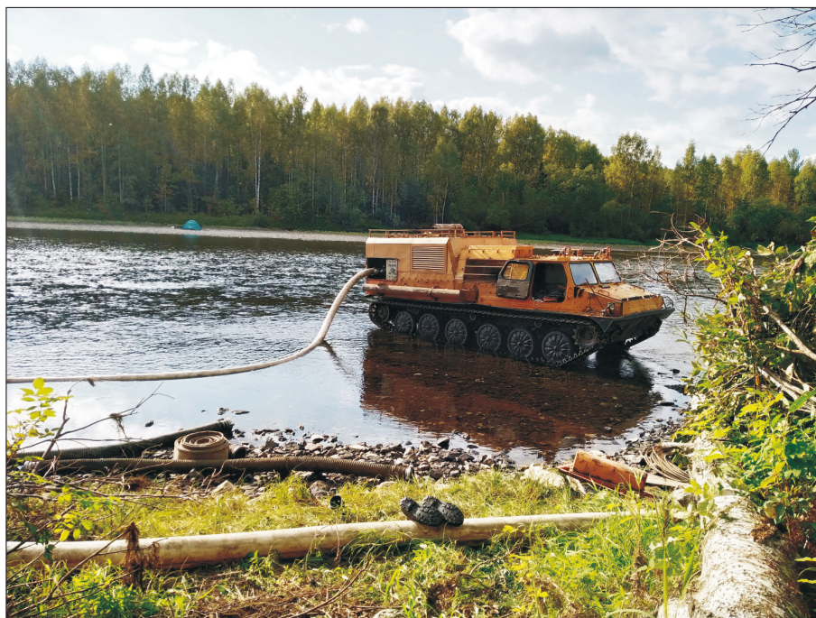
Рис. 6. Насосная станция на базе ГТ-ТМС.
