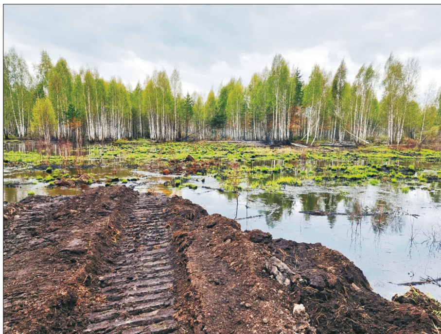
Рис. 5. Гребень плотины и образовавшийся перелив.
