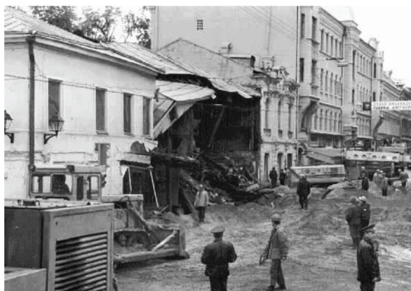
Рис. 1. Здание и проезжая часть улицы, разрушенные суффозионным провалом, образовавшимся в результате фильтрационного разрушения водонасыщенных песков и их выноса в строящийся тоннель (г. Москва, 1998 г.). Фото В.П. Хоменко
