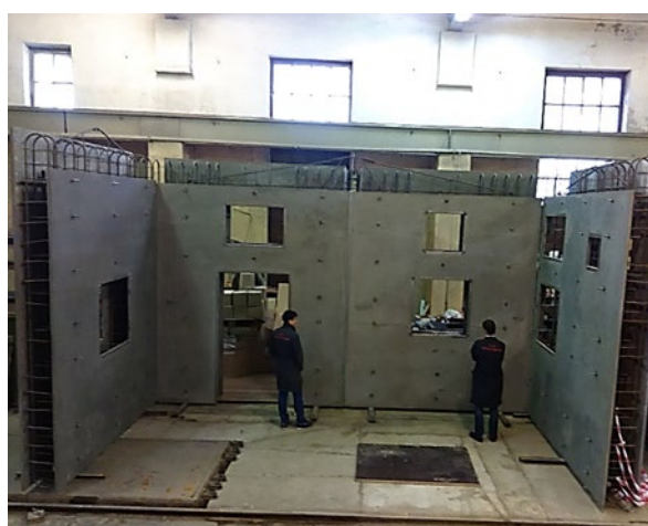
Рис. 1. Фрагмент помещения из армоблоков с несъемной СФБ опалубкой
