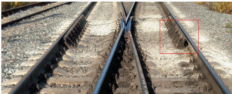
Рис. 3. Стрелочный перевод типа P65, марки 1/11, оборудованный опытными подкладками\*
