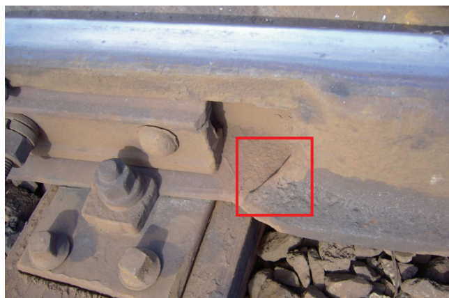
Рис. 1. Трещина в литой части сердечника крестовины типа P50
