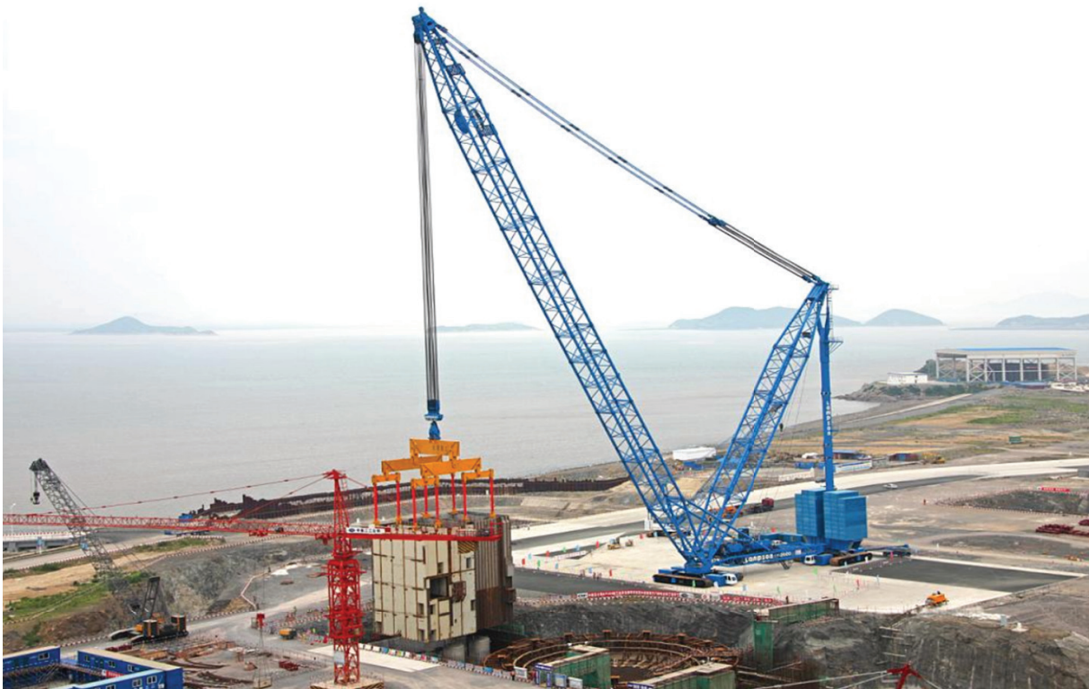
Рис. 15. Монтаж крупного блока CA20 в проектное положение, масса блока — 1000 т, грузоподъемность монтажного крана Lampson — 3200 т, АЭС Sanmen (Китай) [15]
