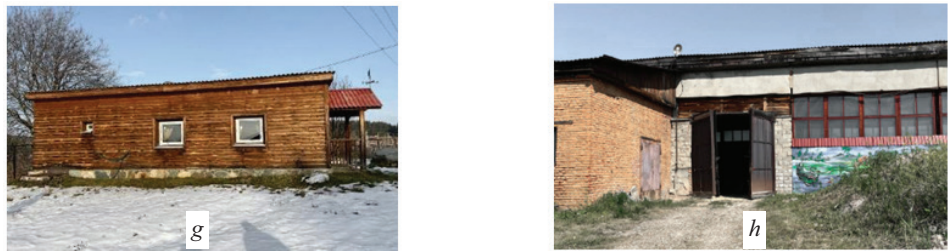
Рис. 4. Фотофиксация территории завода: a — главный вход на территорию; b — выставка уральских минералов; c — территория завода со стороны гостевого комплекса; d — береговая зона р. Нейвы; e — летняя сцена; f — гостевой домик; g — банный комплекс; h — техническая зона
