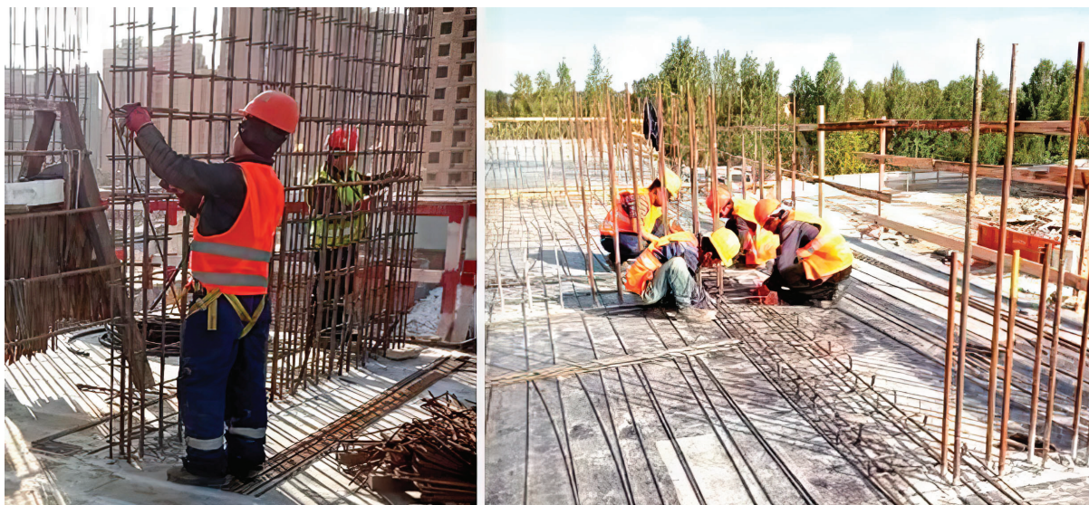
Рис. 2. Сборка каркасов пилона и балки на монтажном горизонте
