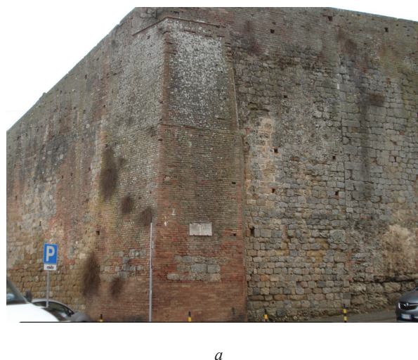
Рис. 2. Разрушение кирпичной кладки исторических зданий из полнотелого красного кирпича: a — крепость св. Варвары (вторая половина XVI в.), г. Сиена, Италия; b — храм Рождества Пресвятой Богородицы в Бутырской слободе (1682–1684 гг.), г. Москва, Россия
