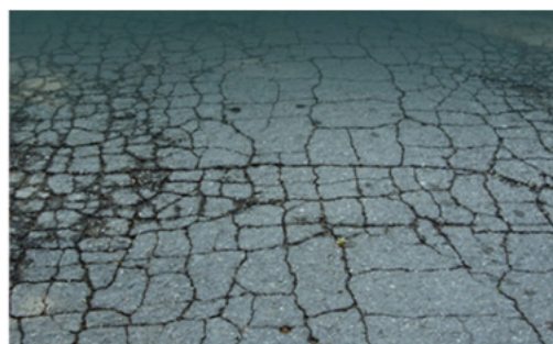
Рис. 3. Механизм формирования «кожи рептилии»
