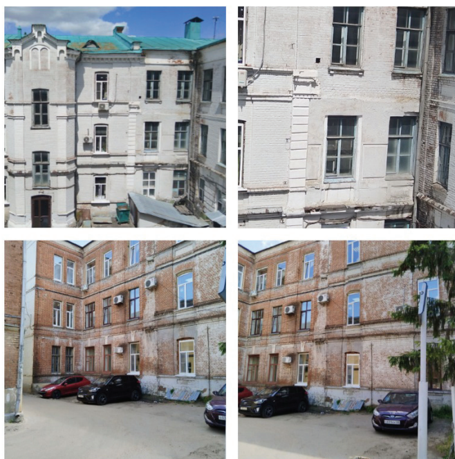
Фото 2. Трехэтажный корпус здания губернской земской управы, пристроенный в 1900–1901 гг. к двухэтажному каменному дому, приобретенному вместе с усадьбой в 1896 г. у домовладелицы Ладан.
