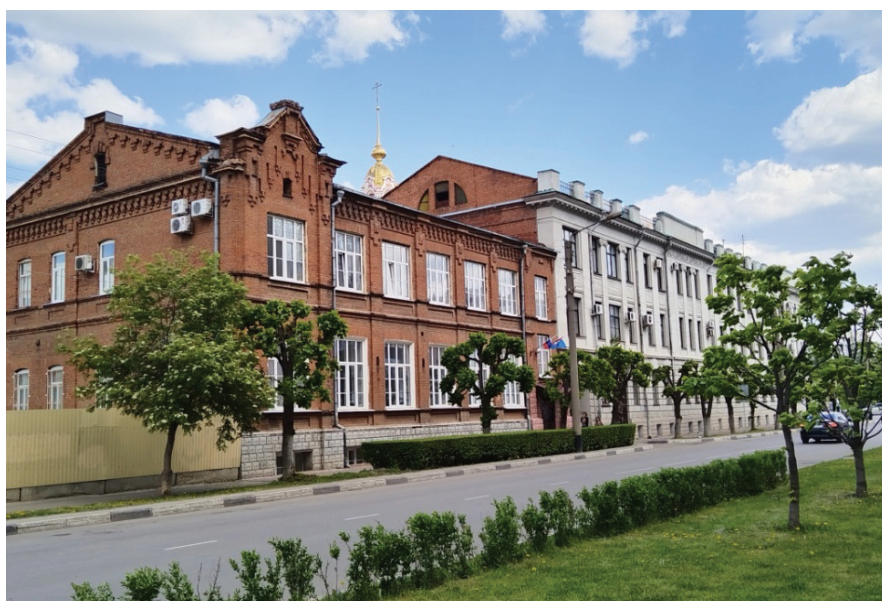
Фото 3. Здание губернской земской типографии. Построено в 1902 г.
