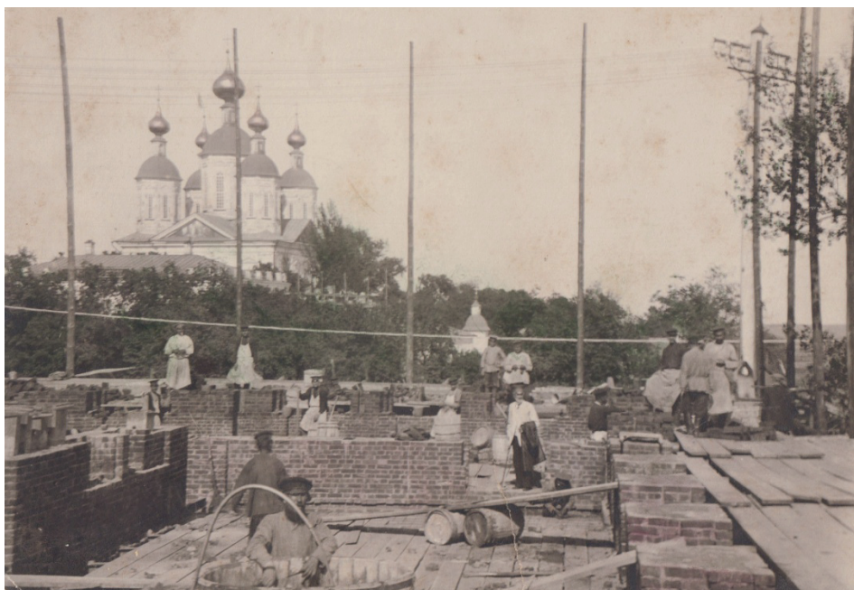
Фото 5. Начальный этап строительства нового здания губернского земства.
